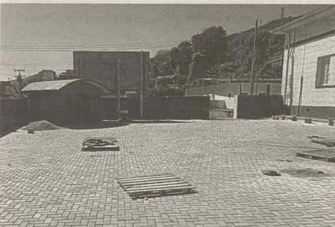
Em fase final, a obra de revitalização da área que dá acesso a entrada do Colégio
